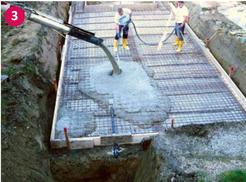
▲ Einbringung von Eisen und Beton in die abgeschaltete Bodenplatte
