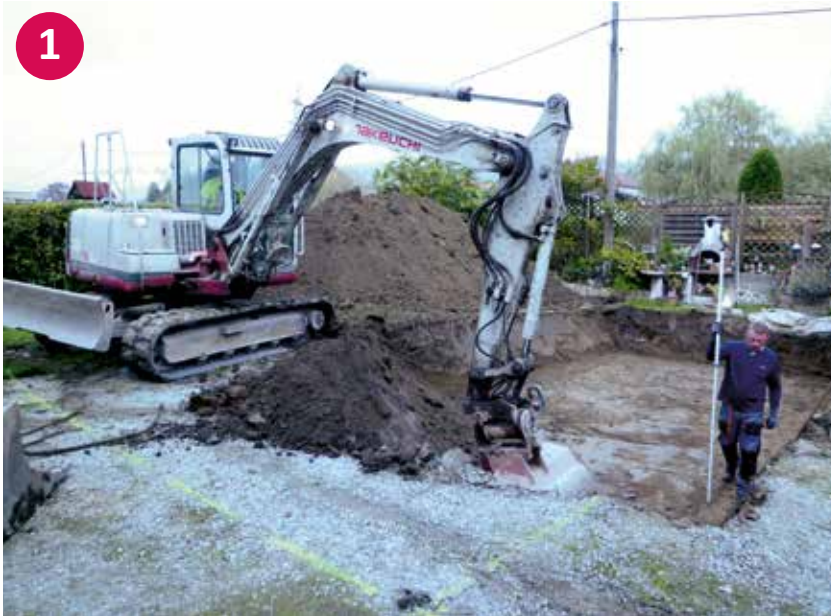
▲ Aushub der Baugrube
