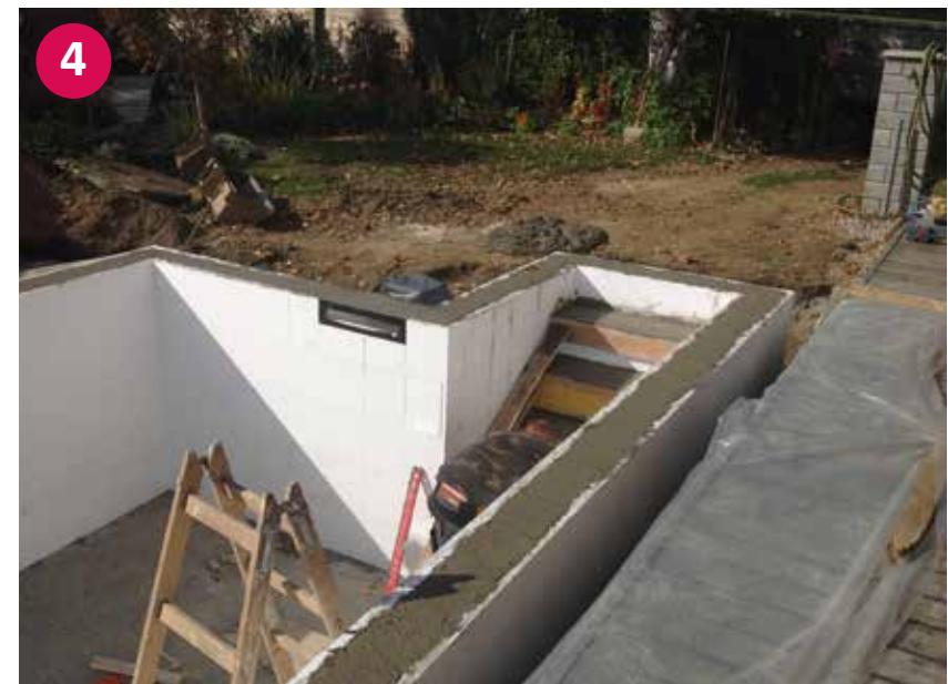
▲ Fertig ausgefülltes Styroporsteinbecken mit Beton
