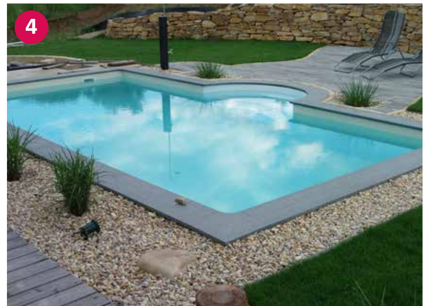
▲ Fertiges Styroporsteinbecken mit Römertreppe
