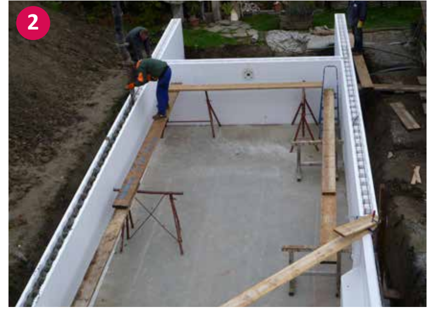
▲ Ausfüllen der Styroporstein mit dem Beton
