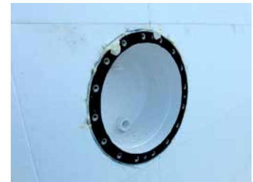
▲ Fertig eingeschäumter Scheinwerfer
