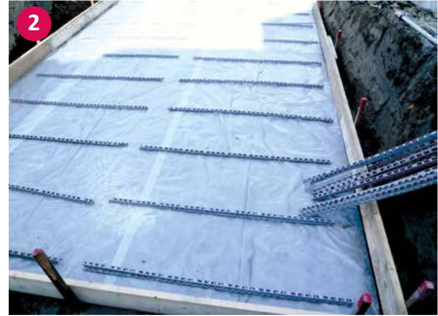
▲ Abschallung der Bodenplatte
