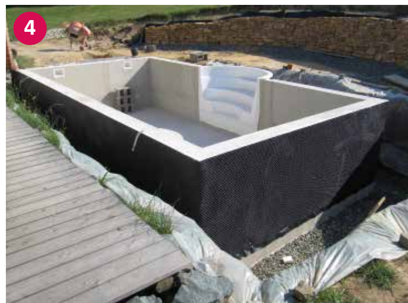
▲ Styroporstein Becken mit Römertreppe, verspachtelte Innenwände und Noppenbahn außen
