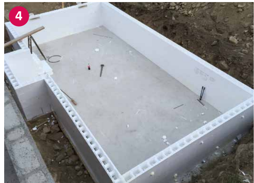
▲ Fertig aufgestelltes Styropor Becken – ohne Betonfüllung
