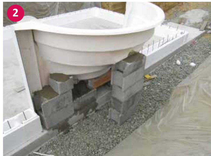
▲ Untermauerung der Römertreppe
