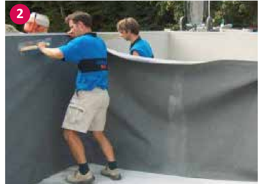
▲ Punktuelle Befestigung der Vliestrennlage mittels Styroporkleber
