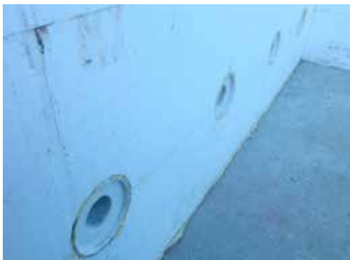
▲ Fertig eingeschäumte Wanddurchführung
