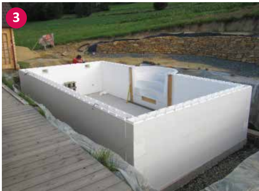
▲ Aufgestelltes Styroporstein Becken mit Römertreppe – ohne Betonfüllung
