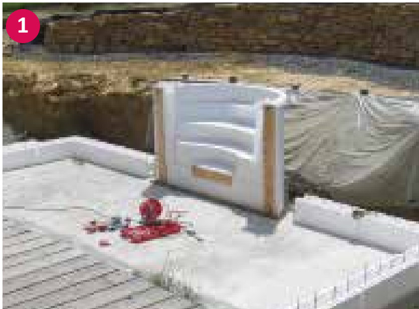
▲ Römertreppe mit erster Ansatzreihe Styroporsteine
