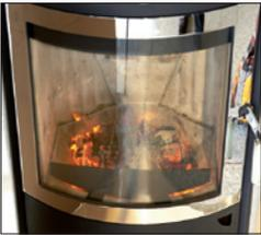
Sekundärluft: Kompletzt geöffnet ("MAX")
