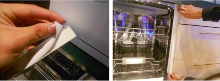
Ausgleichschielen werden eingesetzt, wenn zwischen der Bedienblende und der Möbel Tür ein Spaltentsteht. (Siehe Abbildung unten)
