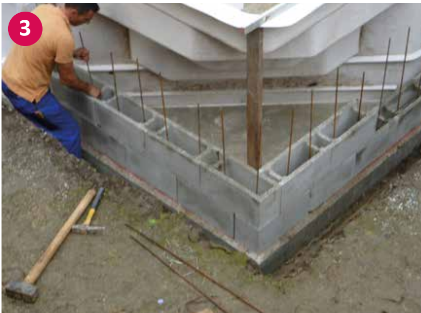
▲ Untermauerung der Ecktreppe
