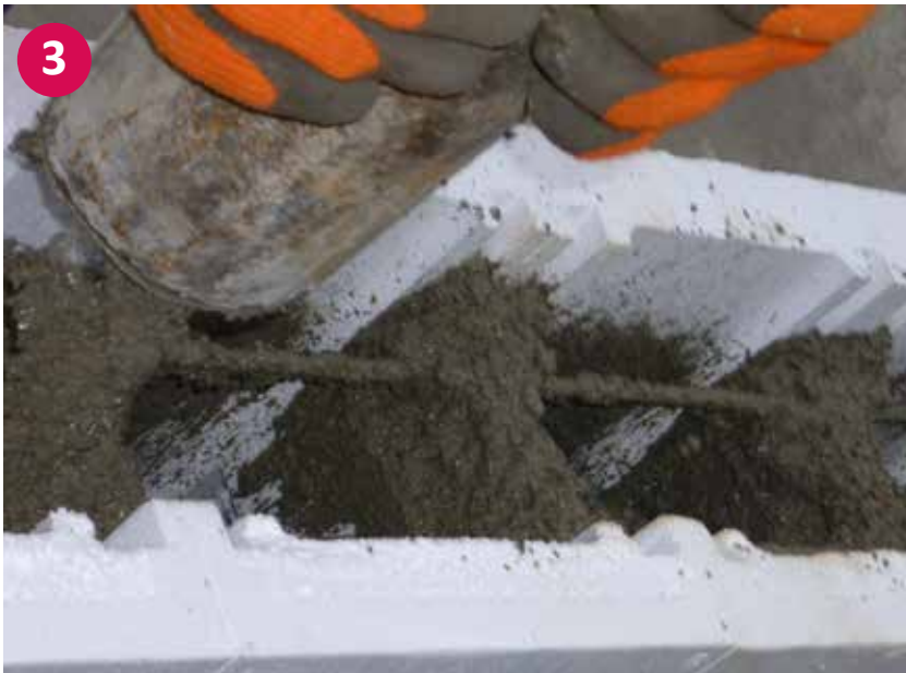
▲ Detailsicht: Ausfüllen der Styroporstein mit dem Beton
