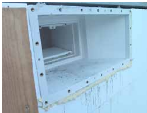
▲ Fertig eingeschäumte WH-Skimmer
