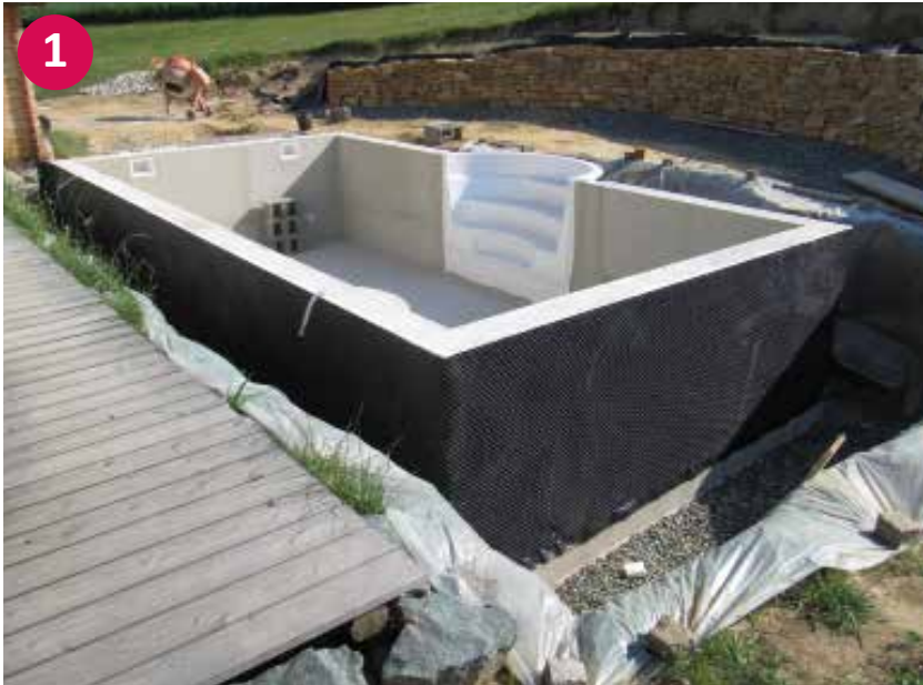
▲ Wir empfehlen die Innenwände zu netzen und zu spachteln
