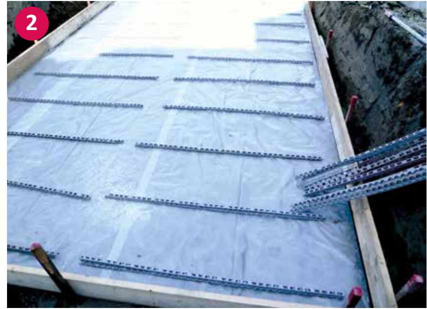
▲ Abschallung der Bodenplatte
