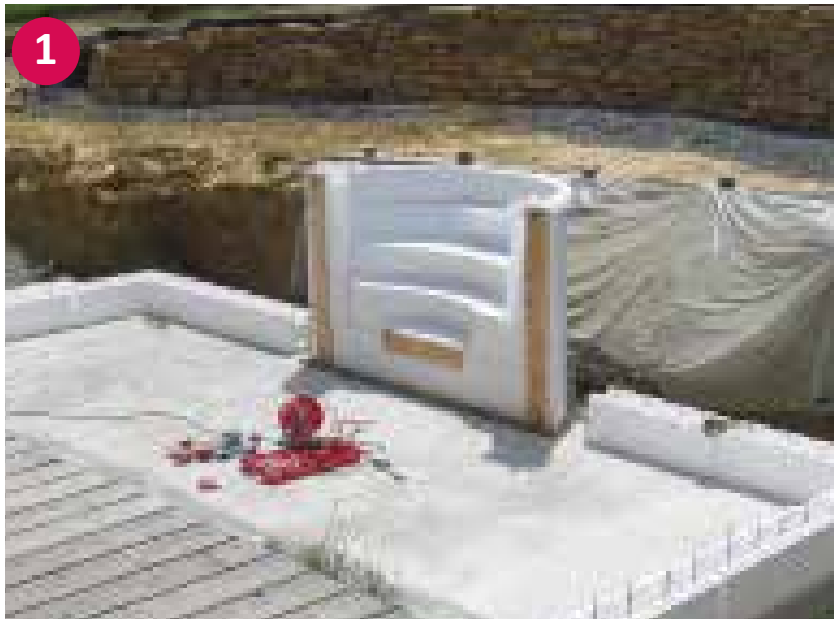
▲ Römertreppe mit erster Ansatzreihe Styroporsteine
