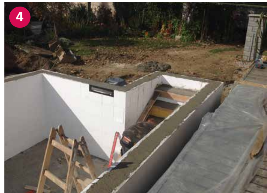
▲ Fertig ausgefülltes Styroporsteinbecken mit Beton
