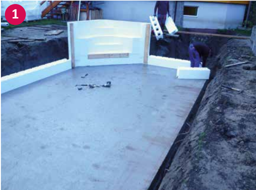
▲ Ecktreppe mit erster Ansatzreihe Styroporsteine
