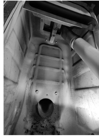
Fig. 77 - Die Asche absaugen
