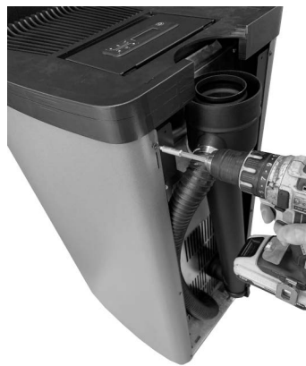
Fig. 29 - Hintere Schrauben entfernen
