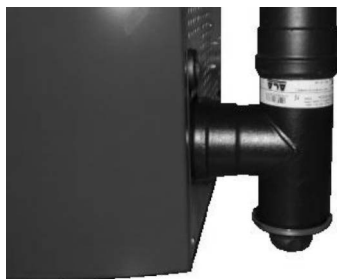
Fig. 71 - Reinigung des Rauchgaskanals
